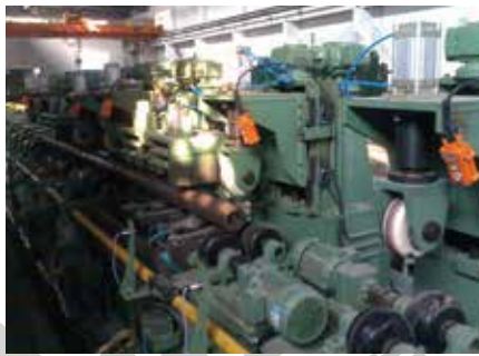
中规格管材探伤系统
